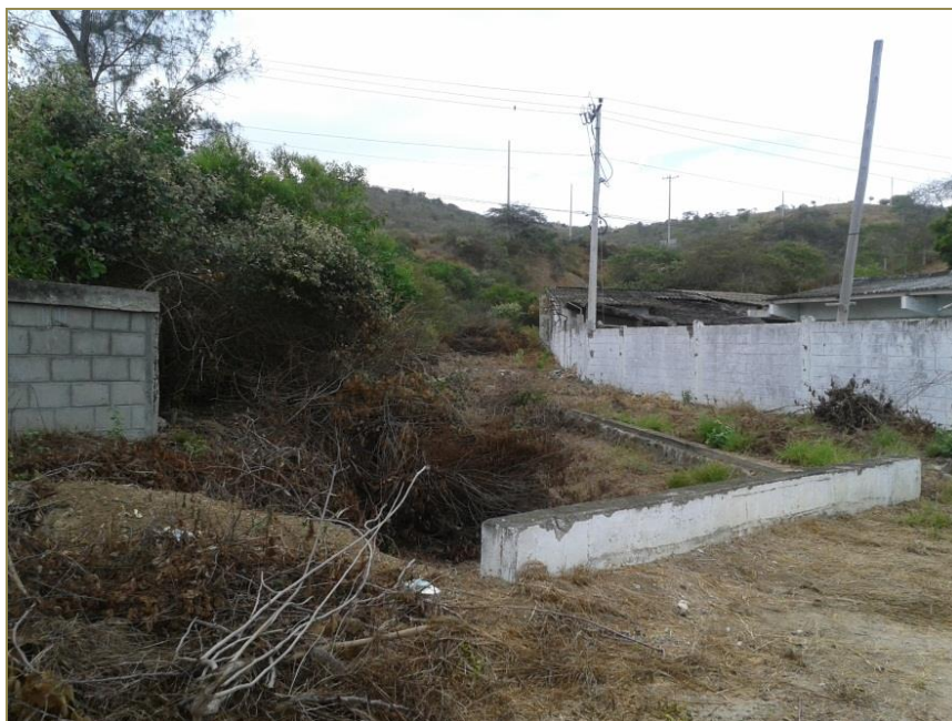
Fotografía 13: Canal de aguas lluvias existente
