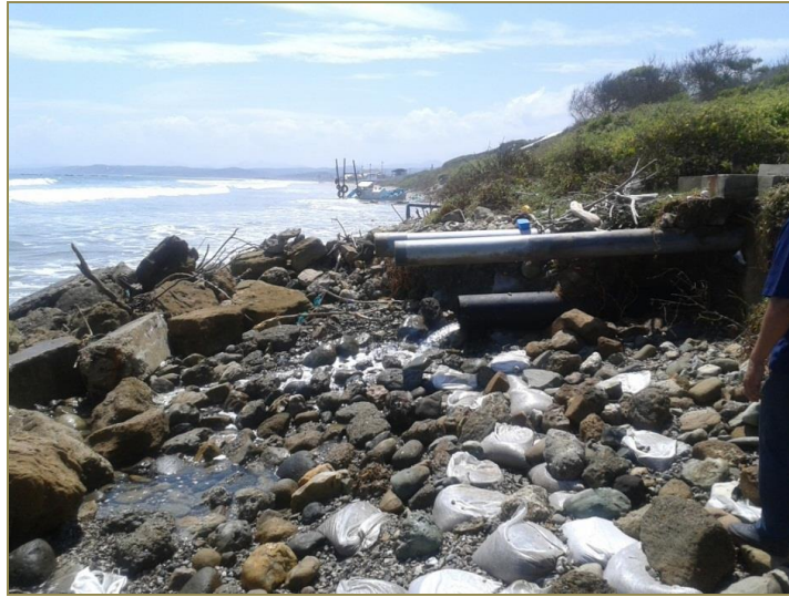
Fotografía 10: Tuberías de descarga de aguas lluvias (estado actual)
